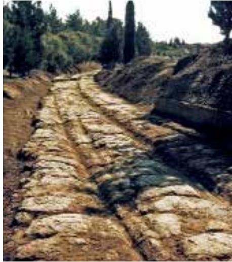
Bu taş döşeli kızak sayesinde tekneler 1000 yıldan uzun süredir Korinthos kıstağında karadan geçiriliyor (fotoğraf 1978 yılında Walter Werner tarafından çekilmiştir).
